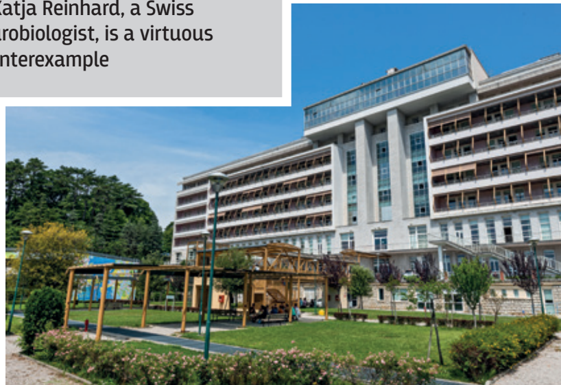
The headquarters of Sissa - Scuola Internazionale Superiore di Studi Avanzati
